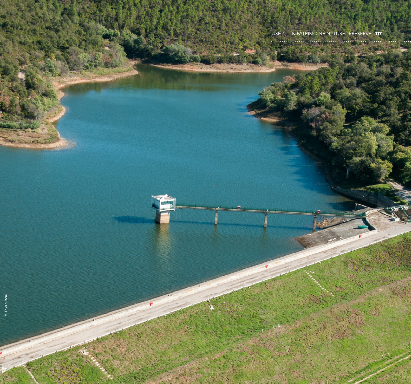
▲ Canal de Provence
