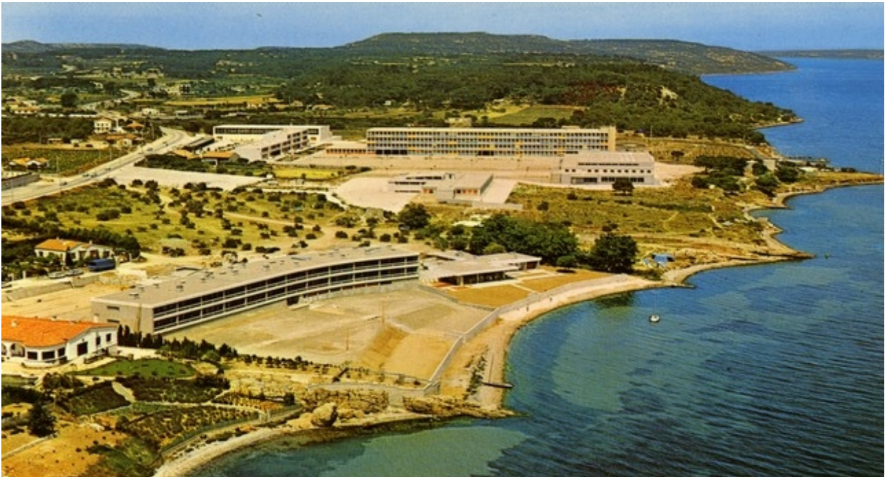
Le lycée Paul Langevin peu après sa construction dans les années 1960. Il est alors en limite de la ville. Au premier plan et sur la droite, la résidence et le site encore non exploré de Tholon.
